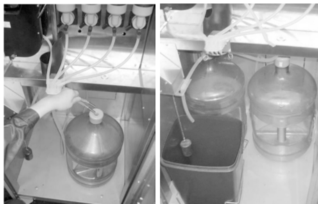
Рисунок 26 - Установка автономного комплекта водоснабжения
